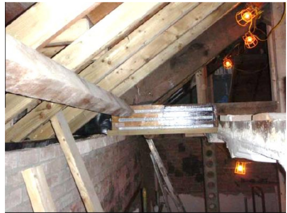
Fig. 29. Span beam repair [18].
